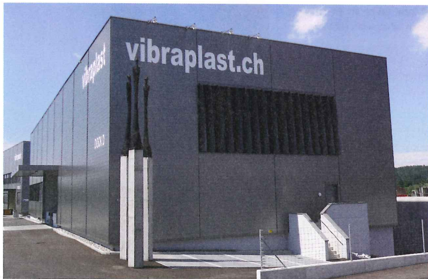
Zeichen des Wachstums: Das Dock D, ein zweigeschossiger und zwölf Meter hoher Bau, wurde im 2013, nach einjähriger Bauzeit, in Betrieb genommen. (Bild: Vibraplast)
